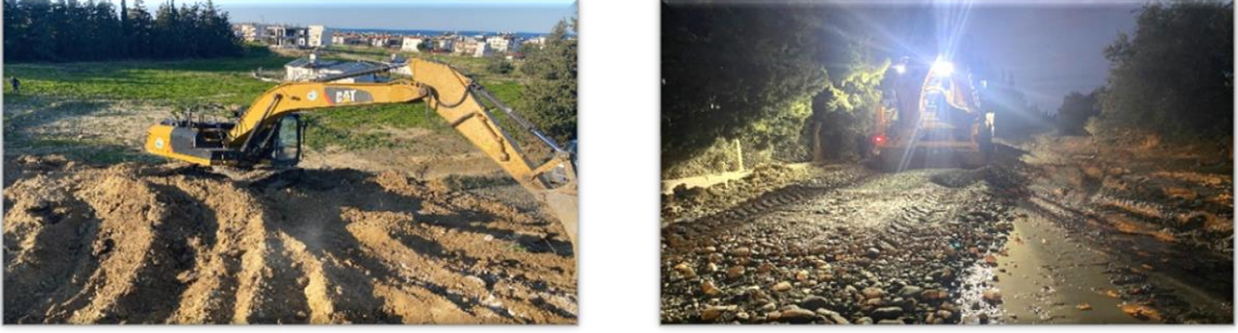
Görsel 19 Yol Yapımı
