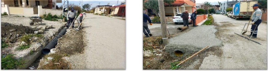
Görsel 16 Menfez-Köprü-Kanal Yapımı
