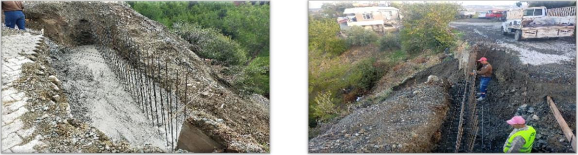
Görsel 17 İstinat Duvar Yapımı
